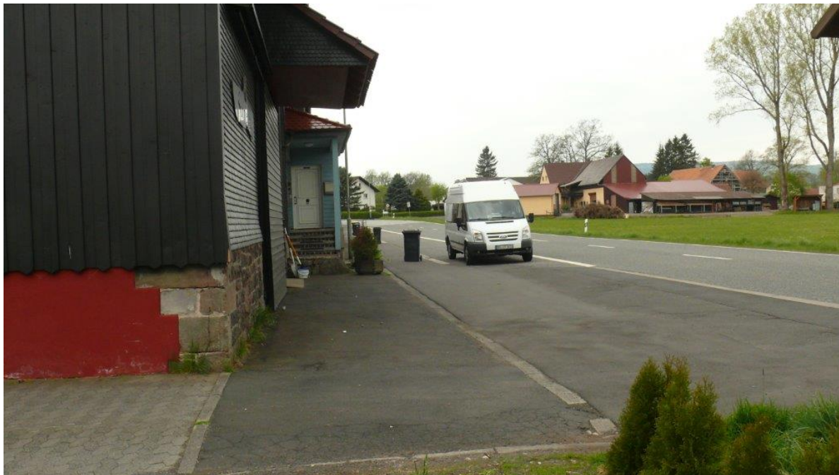
Abbildung 6: Foto von der bestehenden Zufahrt in Blickrichtung Ortslage (SW)
